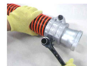
4. レンチで均等に締めて完了。
